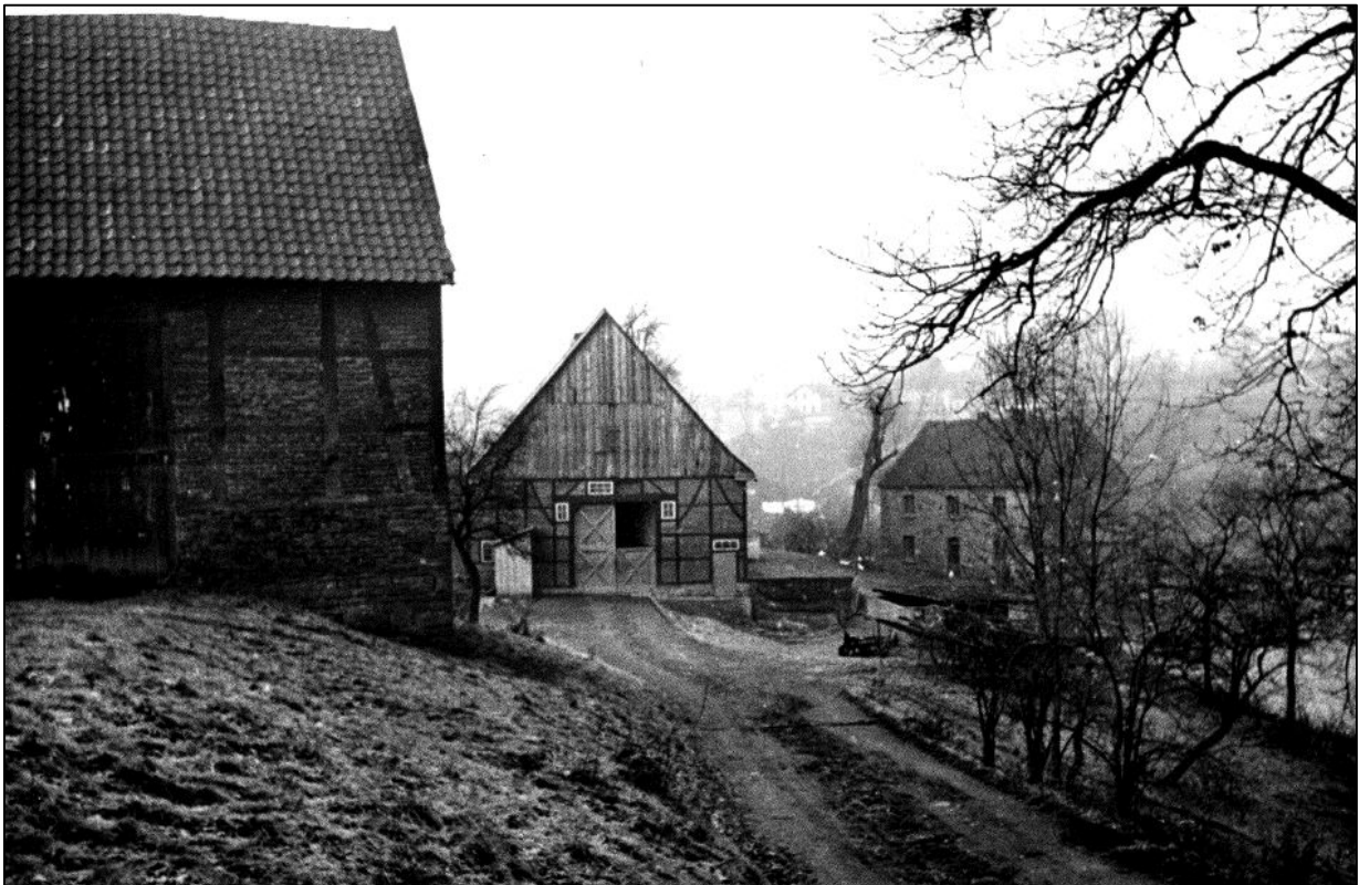
Abbildung 1: Ansicht des Hof's von Südosten (um 1942). Original im Stadtarchiv Hattingen. In der Mitte das Haupthaus, vorne links die Scheune, rechts, dem Bachlauf zunächst, das Altenteilerhaus.
